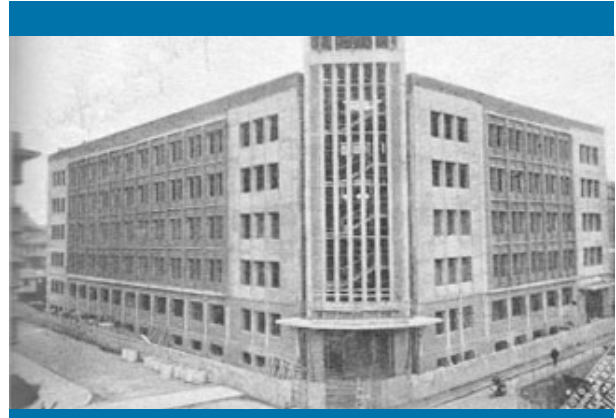
Figura 5. Edificio en construcción para Casa de Familia, cabida para 80 niños internos, y Hospital Infantil para 60 camas o cunitas, con su sección de prematuros
